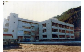
昭和53年初め頃 新築校舎 まだ体育館はない。
